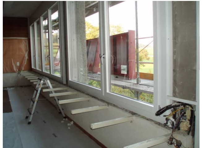
Schon nach einem Tag sind in unserem Schulzimmer alle Fenster neu eingebaut.
