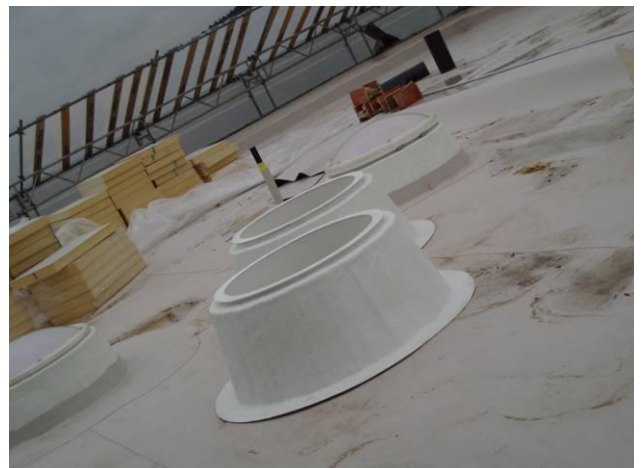
Auch die neuen Oberlichter sind zur Montage bereit.
