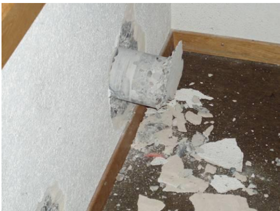
Durchstich der Kernbohrung in ein Schulzimmer.
