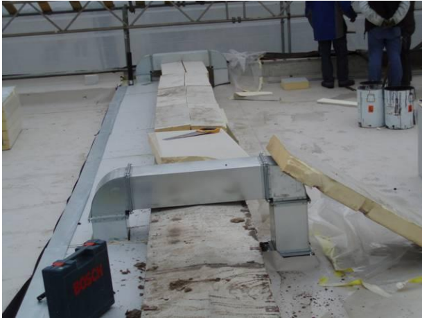
Auch Lüftungskanäle für die Versorgung der Schulzimmer mit Frischluft sind schon da.
