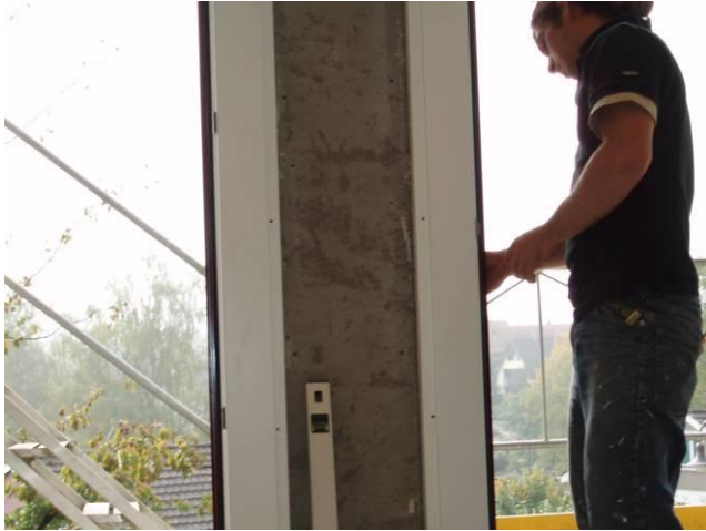
Ein Monteur befestigt die neuen Fenster.
