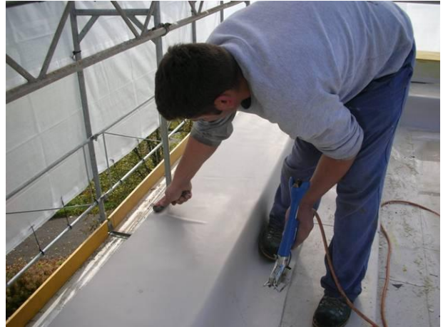
Ein Arbeiter erstellt einen wasserdichten Abschluss.
