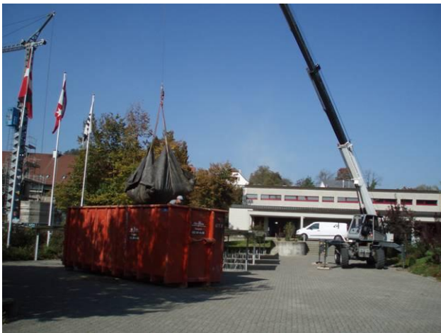
Der Kies vom Dach wird in grossen Kunststoffsäcken mit einem Kran in einen Container transportiert.
