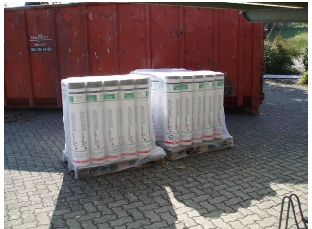
Die neuen Abdeckplanen, die auf dem Dach verlegt werden, stehen schon bereit.
