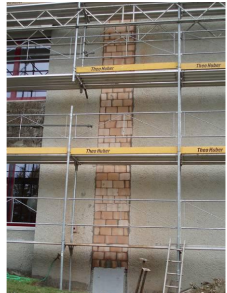
Das Eisengestell ist montiert und der Schlitz schon wieder zugemauert.
