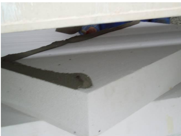
Damit man die Isolierplatten an der Aussenwand festkleben kann, streicht man an den Rand der Styroporplatten Klebstoff.
