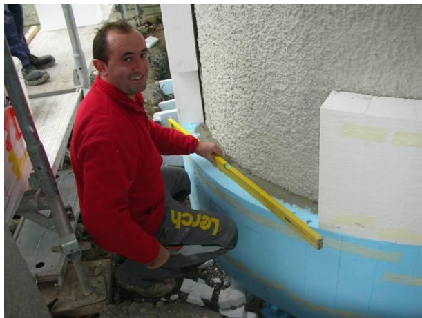
Ein Fassadenbauer kontrolliert mit einer Wasserwaage seine Arbeit.
