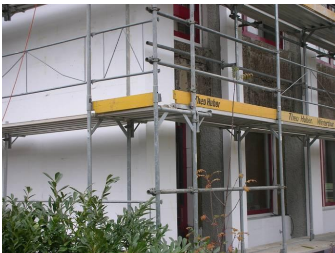
Fast alle Wärmedämmplatten sind am Schulhaus befestigt. Die Mauern sind viel dicker geworden.
