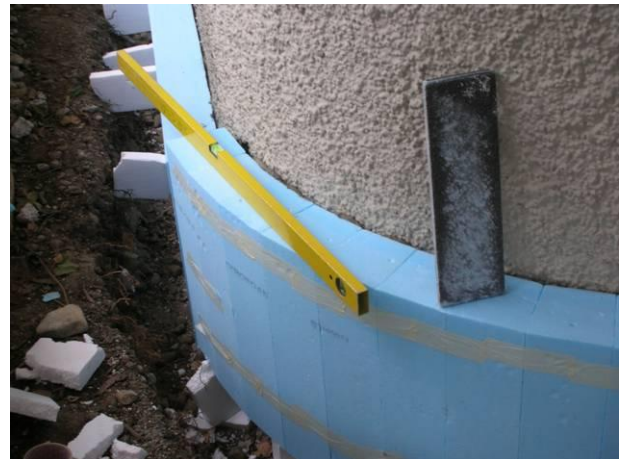
Rundungen werden mit vielen kleineren Styropor-Platten versehen.
