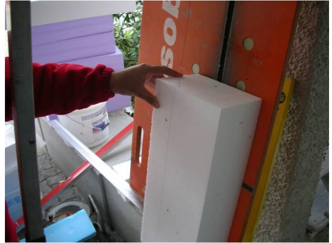
Ein Arbeiter schneidet mit einem Wärmeschneidergerät eine Platte auf die richtige Masse.
