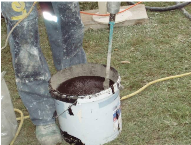
Ein Bauarbeiter vermischt maschinell Bitumen, eine wasserundurchlässige, klebrige Masse.
