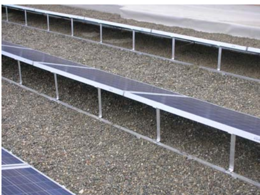
Sechzig in Serie geschaltete Solarzellen ergeben ein sog. Modul
