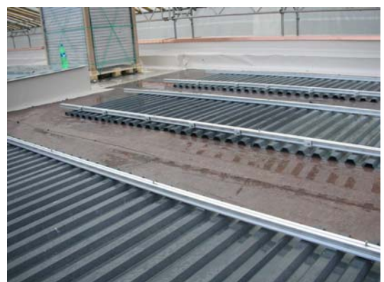
Der Unterbau der Anlage ist fertig erstellt
