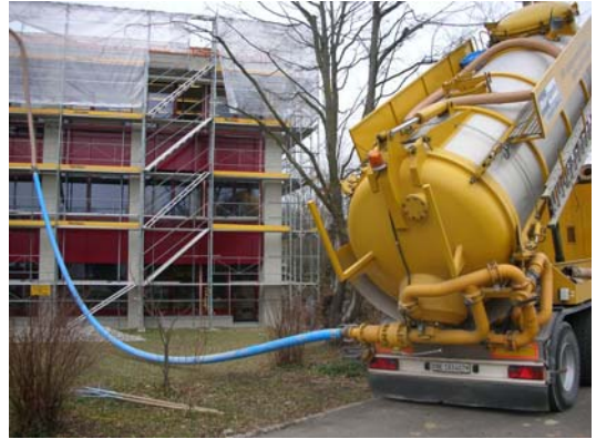
Der Laster pumpt mit nötigem Druck das Material auf das Dach
