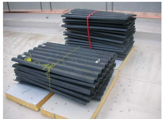
Bodenplatten stehen für die Verwendung bereit
