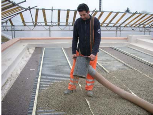
Ein Arbeiter verteilt Kies auf den Kunststoffplatten
