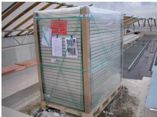
Bestandteile der Solaranlage sind mit dem Kran auf das Dach gehievt worden
