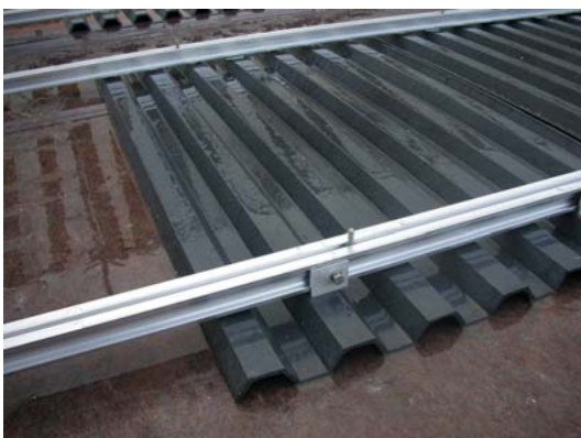
Aluschienen werden auf den Grundplatten festgemacht
