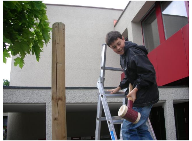
Jetzt noch die Pfähle ...
