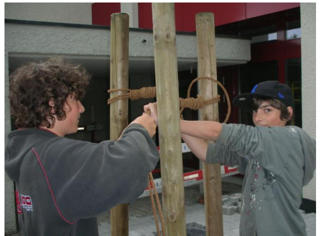
Tobias und Alessio befestigen die Stämme mit „Kokos-Seilen“ an den Pfosten.
